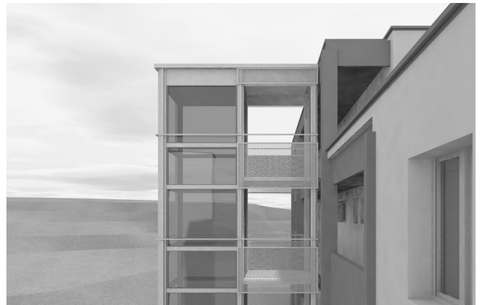
Hausgruppe 1: Laubengang mit Liftanbau
