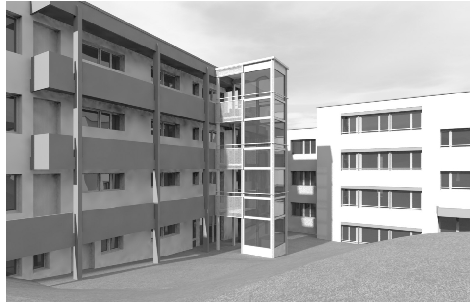
Hausgruppe 1: Laubengang mit Liftanbau
