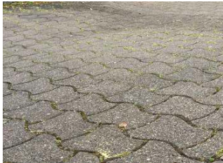
Bestehende Betonverbundsteine
