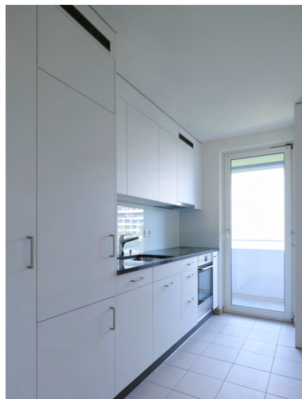
Auf die neue Küche (ein Beispiel aus den Häusern 47–71) und die neuen Bäder dürfen sich die Mieter:innen der Häuser 48–52 bereits jetzt freuen.
