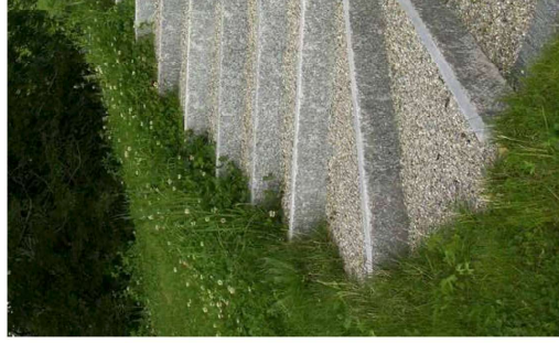
Treppe mit Naturstein-Stellplatten
