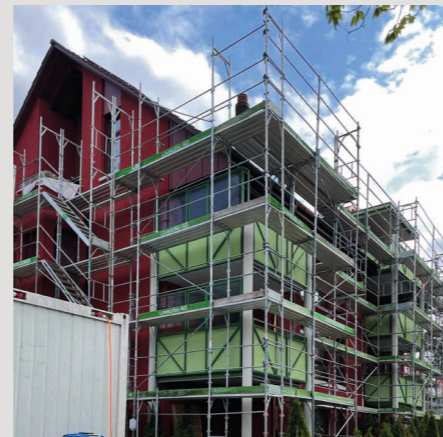
Blick auf das eingerüstete Gebäude an der Rietstrasse 29 während der Maler- und Metallbauarbeiten.
