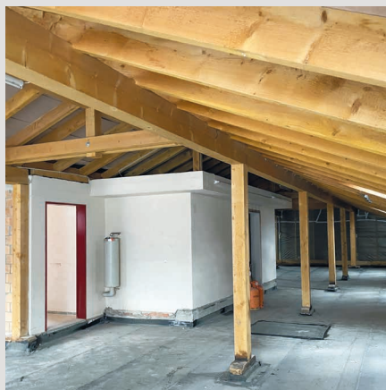
Die bestehenden Häuser an der Hirzenbachstrasse erhalten zusätzliche Dachgeschosse.
