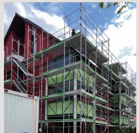
Blick auf das eingerüstete Gebäude an der Rietstrasse 29 während der Maler- und Metallbauarbeiten.
