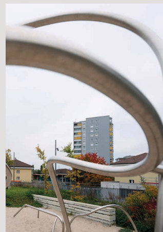
Zur Titelseite: Das Hochhaus der Siedlung Luegisland (Nr. 141) wird ab 2029 saniert und bis dahin auch für Wohnungsrochaden genutzt.
